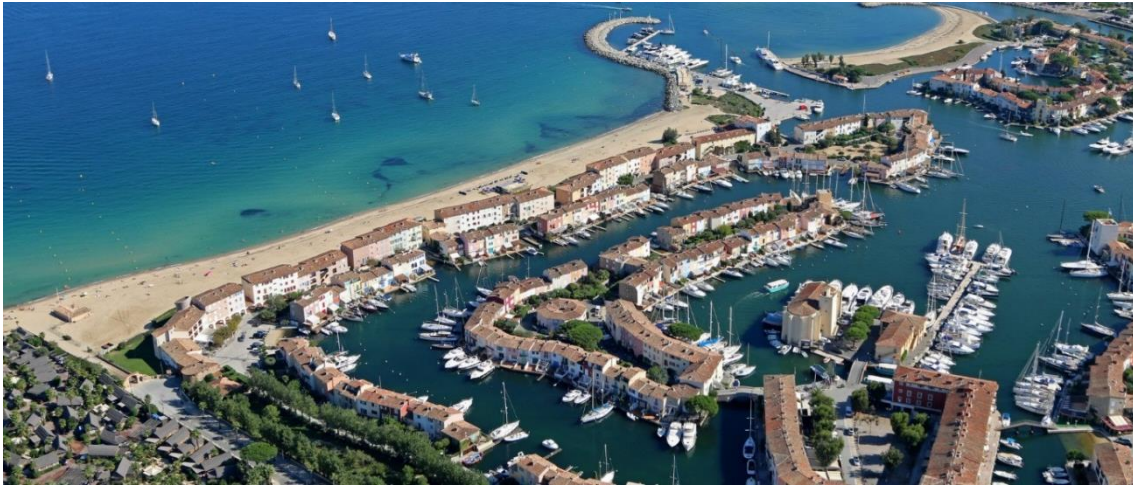
Şekil 3 – Port Grimaud Genel Görünüşü ( http://www.grimaud-provence.com/fr/decouvrez/cote-mer )
