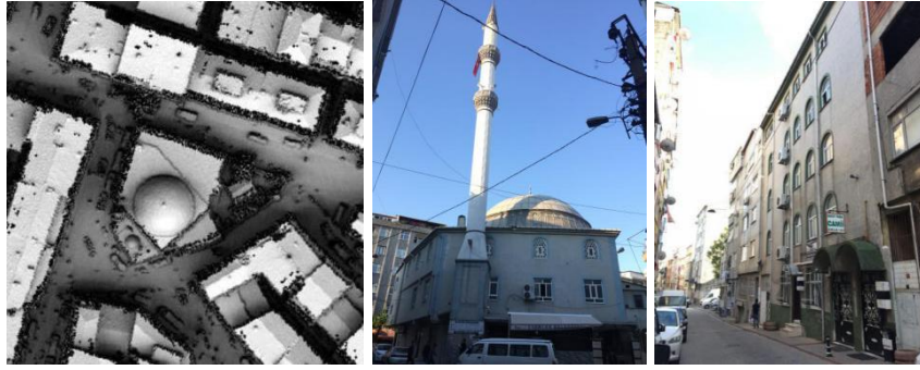
Şekil 14: Esenler Kazım Karabekir Camii (1974) (solda) (İsimsiz, 2018) (Akar, 2018)
