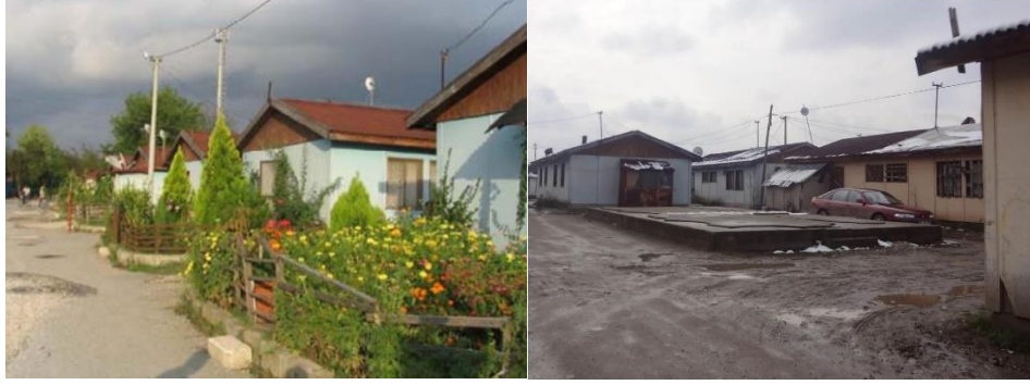
Şekil 2: Kiremit Ocağı Geçici Barınma Yerleşkesi a) 2008 yılı yerleşke halkının oluşturduğu bahçeler (Johnson, 2008) b) 2015 yılı deforme olmuş geçici konutlar (Ceylan,2015)
