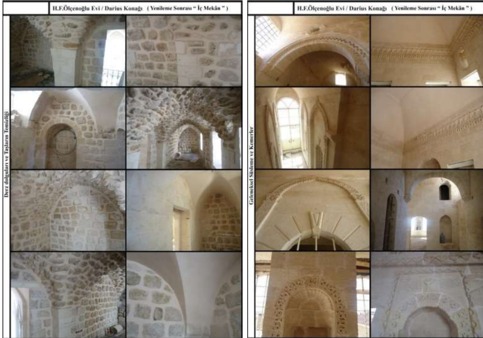
Çizelge 11: Derzlerin Harç ile Doldurulması ve Kararan Bölümleri Temizliği (Güler, 2012, düzenleme: Ayanoğlu) Çizelge 12: Sıvalardan Temizlenerek Detay İşçiliği Yapılan Süslemeler (Güler, 2012, düzenleme: Ayanoğlu)
