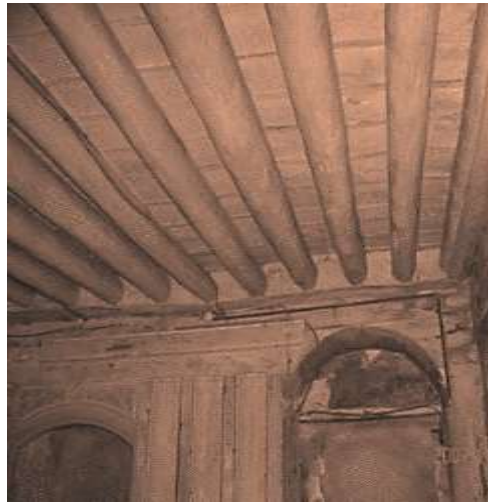
Şekil 5. İç mekânda tavanda ve duvarlarda ahşap kullanımı (Kaleoğlu Kanalcı, 2022)
