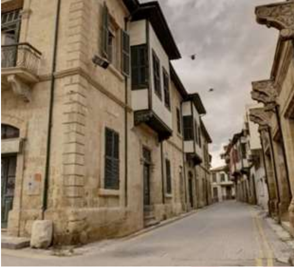
Şekil 11. Lefkoşa Surlariçi yerel mimaride İki katlı yapılar (URL 3).
