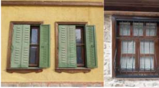
Şekil 15. Oruç Bey Caddesi sağlıklaştırma projesi kapsamında onarılan ve yenilenen pencere sistemleri (Yazar, 2024).
