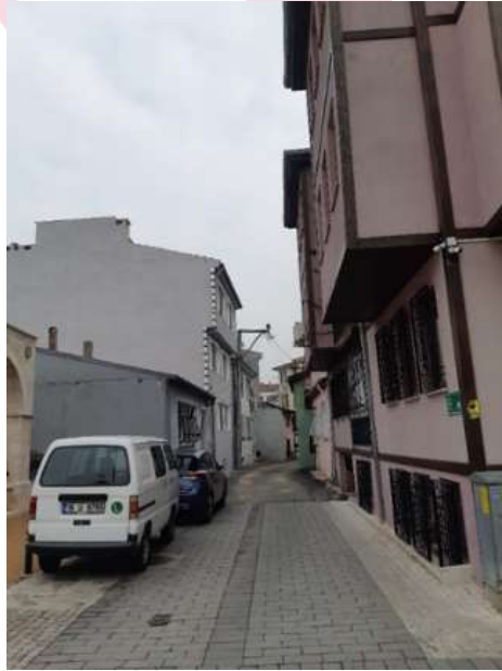
Şekil 6. Oruç Bey Caddesi bağlantılı yan sokaklardaki bina görünümleri (Yazar, 2024).
