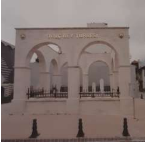
Şekil 7. 2011 yılına ait Oruç Bey Türbesi Genel Görünüş (Dostoğlu & Dostoğlu, 2011).
