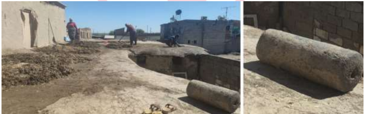
Şekil 2. 37 nolu kerpiç konutun düz toprak terasının onarımından bir görüntü ve loğ taşı (Serpil Ö. Biroğlu - 2022)
