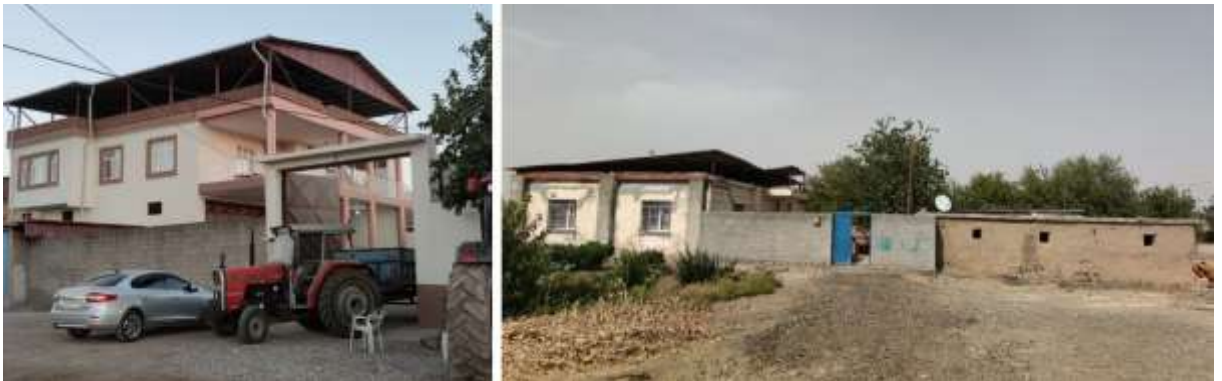
Şekil 5. Kerpiç konutun yakınına inşa edilen yeni konutlar (solda 2 ve sağda 13 nolu konutlar) (Serpil Ö. Biroğlu – 2022)
