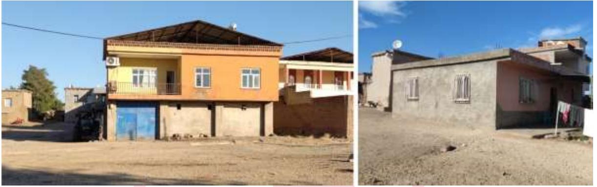
Şekil 4. Eğimli (solda 4 nolu konut) ve düz teras çatılı (sağda 57 nolu konut) konutlar (Serpil Ö. Biroğlu – 2022)
