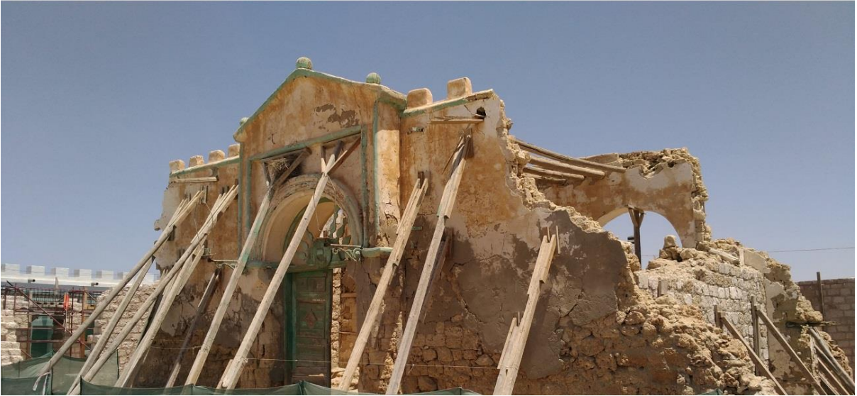
Şekil 18: Gümrük Muhafaza Konağı (Kate Ashley arşivi)ve restorasyonu, 2018 (Ahmet Cemal Dağ arşivi)
