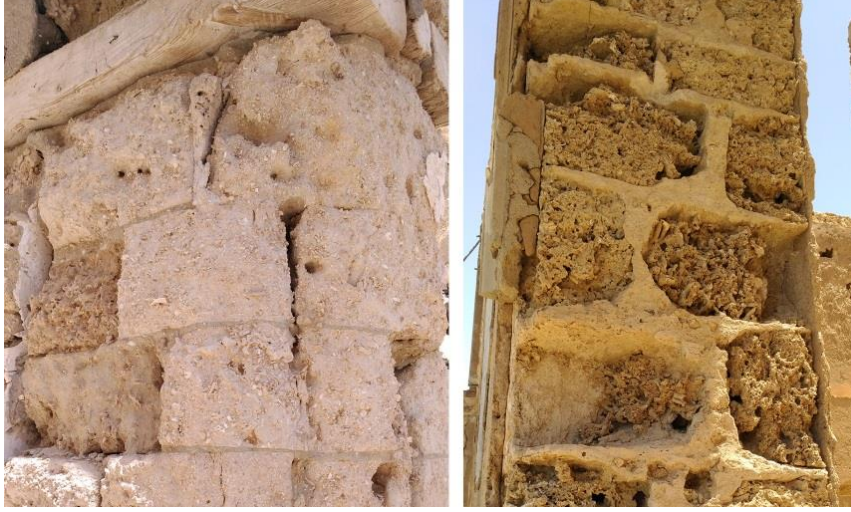
Şekil 24: Mercan kayalarıyla inşa edilmiş duvar, 2018 (Ahmet Cemal Dağ arşivi)
