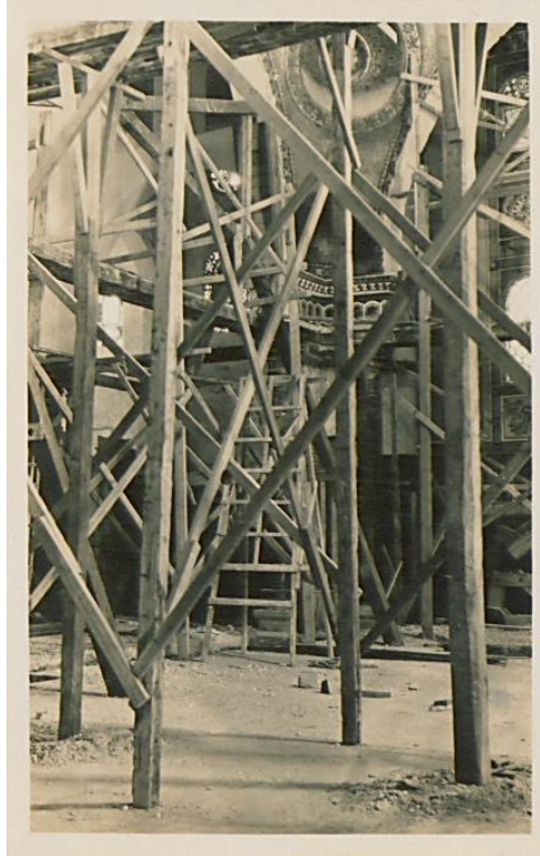
Şekil 7: Mescid-i Aksa Cami iç mekân onarımı url[12]
