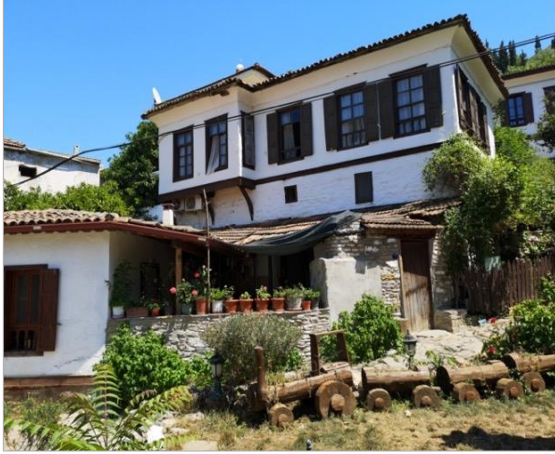
Şekil 5a. Kısmi cumbalı yapı (Web 5)
