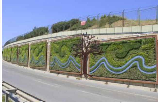
Şekil 17. Ünalın Dikey Bahçe Uygulaması, İstanbul (Url 16)
