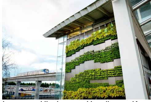
Şekil 12. Vancouver Uluslararası Havalimanı, Kanada (Url 11)
