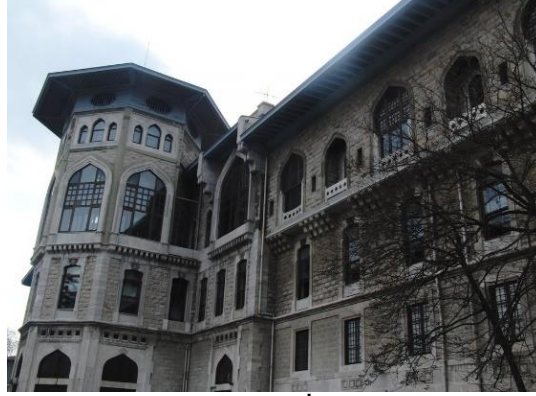
Şekil 2. Düyûn-u Umûmiye İdaresi Binası (URL-2)
