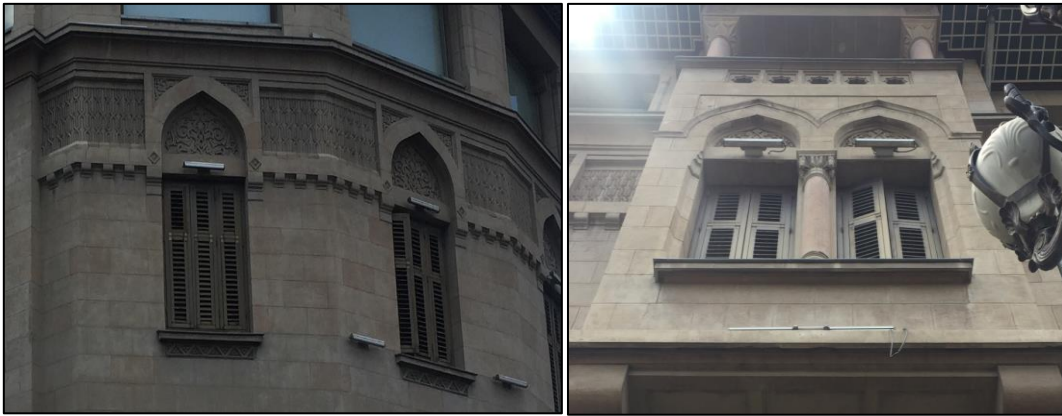
Şekil 22. Pencerelerin bağlantı detayları ve giriş cephesinde bulunan ikiz pencereler (Aylin Kaya, 2020)
