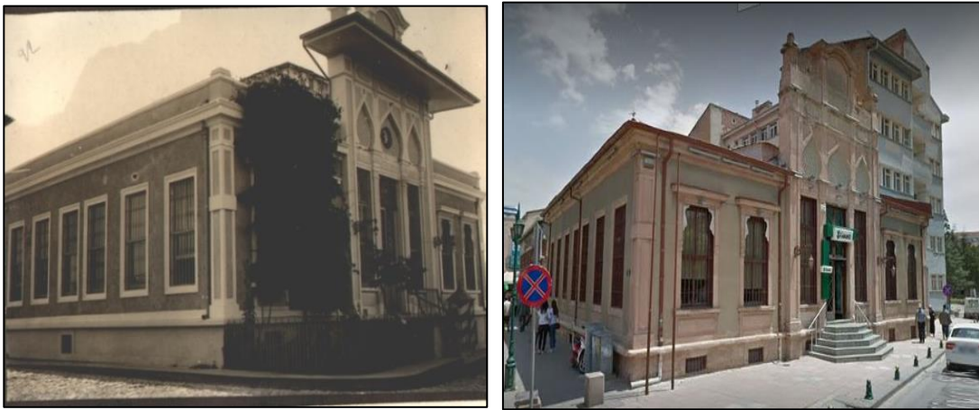
Şekil 10. Eskişehir Şubesi, 1930 (URL-5) ve günümüz görüntüsü (URL-8)
