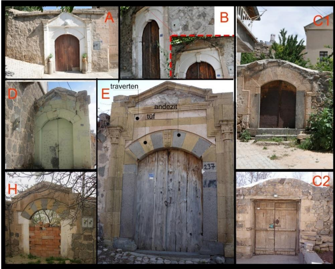
Şekil 10: Üçgen alınlıklı düz basık kemerli avlu kapıları örnekleri; 214 nolu avlu kapısı (A), 235 nolu avlu kapısı (B), üçgen alınlığı tahrip olmuş avlu kapısı örneği ön görünüş (C1) ve arka görünüş (C2), 207 nolu avlu kapısı (D), 237 nolu avlu kapısı (E), ahşap kapı kanatları olmayan kapı açıklığı örülerek kapanmış avlu kapısı (H) (İ. Acar Ata - 2022)
