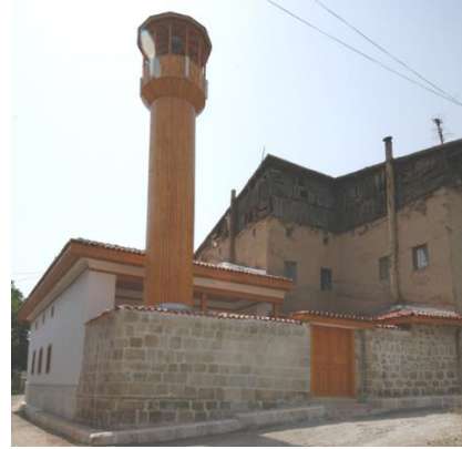
Şekil 13. Zelihatun Camii Restorasyon Sonrası (M. Yeğın - 2020)
