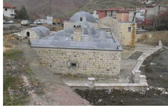
Şekil 17. Aşağı Hamam Restorasyon Sonrası (M. Yeğın - 2010)
