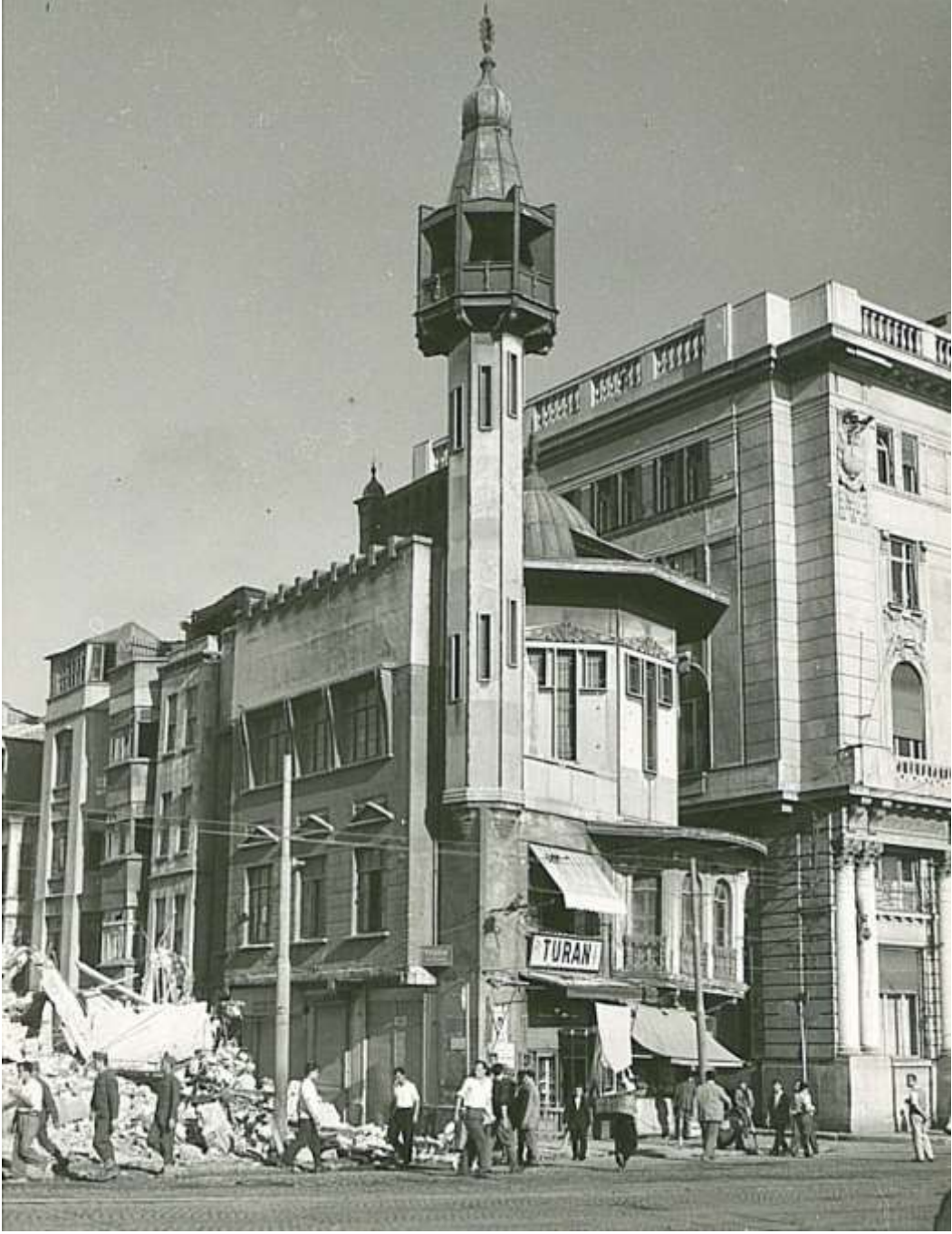
Şekil 49 Havyar Han yıkıldıktan sonra, caminin kuzey (giriş) cephesi tamamen görülebiliyor [Fotoğrafçı bilinmiyor]. (1958). Salt Araştırma, Ülgen Ailesi Koleksiyonu, Kod:TASUH0975.
