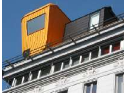
Şekil 3. Viyana'da çatı yenilemesi. (E. Arça - 2011).
