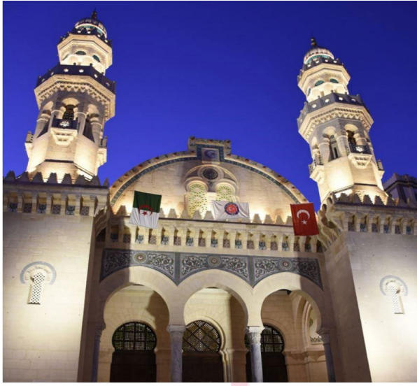
Şekil 12: Restorasyon Sonrası Keçiova Camisi, TİKA.
