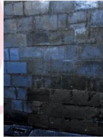
Şekil 19. Gaziantep hamamlarının cephelerinde gözlemlenen tuzlanmalar
