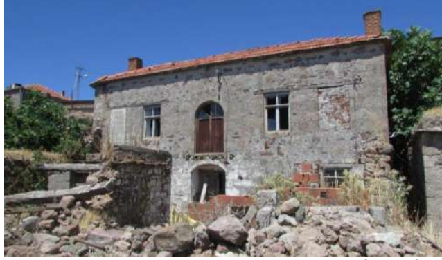
Şekil 25: Geleneksel Bir Yapıda Görülen Açık Çıkmanın İzleri (İ. Çeliker - 2021)
