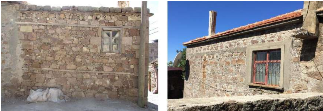
Şekil 14: Ahşap ve Beton Hatıllı Geleneksel Yapılardan Örnekler (İ. Çeliker - 2021)
