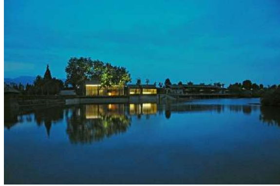
Şekil 7: Çay Evi'nin Su Rezervuarından Görünümü, (Belogolovsky, 2019)
