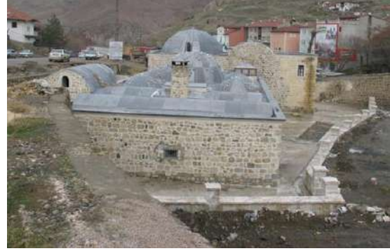
Şekil 17. Aşağı Hamam Restorasyon Sonrası (M. Yeğin - 2010)
