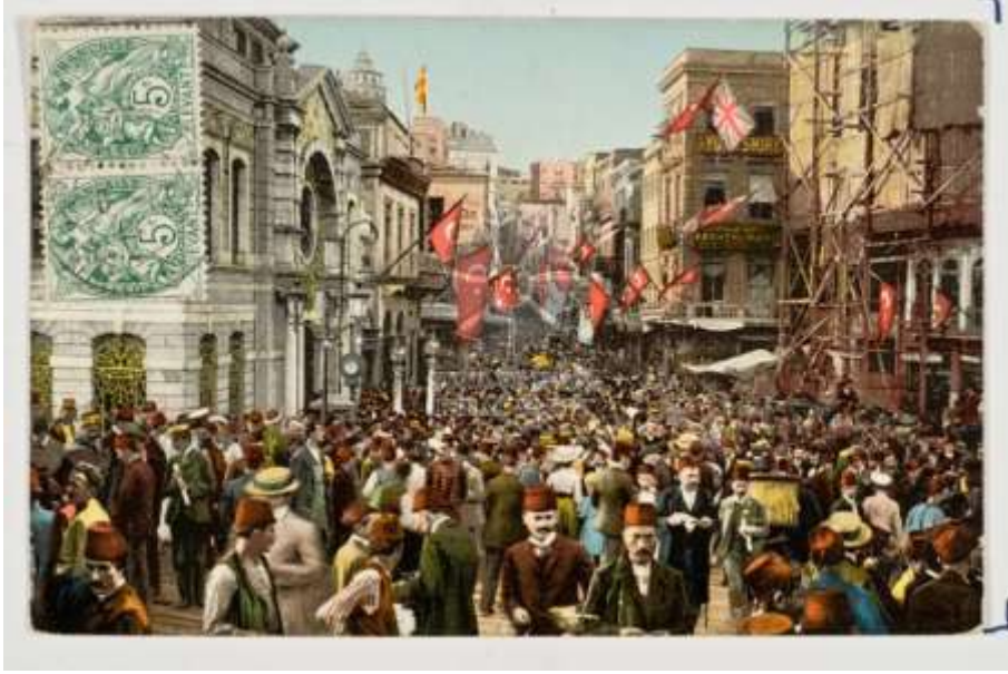
Şekil 9 Karaköy Camisi'nin inşaatı sürerken, caminin cephesinde iskeleler kurulu. Sol tarafta Aziziye Karakolu görülmektedir [Fotoğrafçı bilinmiyor]. (t.y.). A6_Kutu_004 (Demirbaş no. FKA_004699), İAE, İstanbul.
