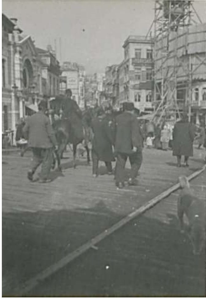
Şekil 8 Karaköy Camisi'nin inşaatı sürerken, caminin cephesinde ve minarenin çevresinde iskeleler kurulmuş [Fotoğrafçı bilinmiyor]. (t.y.). Koç Üniversitesi Dijital Koleksiyonu.
