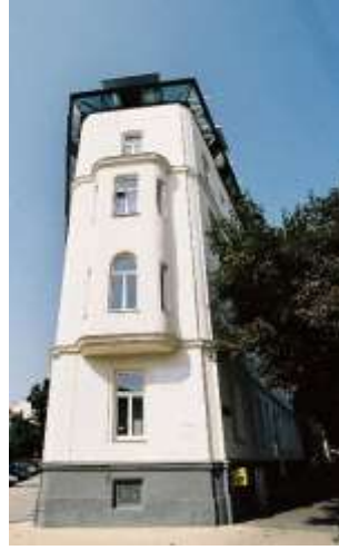
Şekil 4. Viyana'dan çatı, Breitenseerstraße 13. (E. Arça - 2011).
