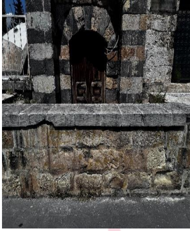
Şekil 18. Gaziantep hamamlarının cephelerinde gözlemlenen renk değişimleri
