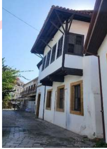
Şekil 16. Lefkoşa Surlariçi yerel mimaride sokak cephesi (Yazar, 2024).
