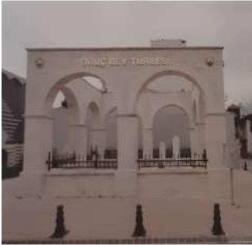
Şekil 7. 2011 yılına ait Oruç Bey Türbesi Genel Görünüş (Dostoğlu & Dostoğlu, 2011).
