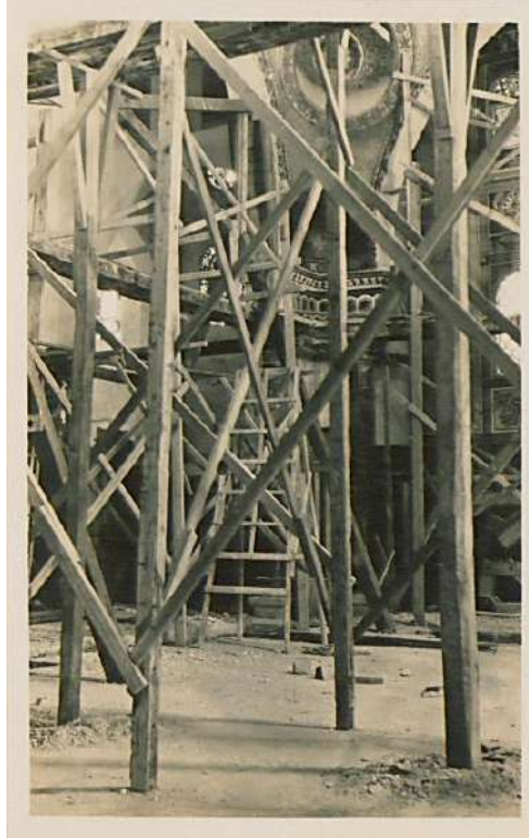
Şekil 7: Mescid-i Aksa Cami iç mekân onarımı url[12]
