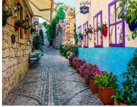
Şekil 11b. Alaçatı sokak ve yapılar arasında ilişki (Web 12)
