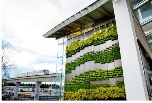
Şekil 12. Vancouver Uluslararası Havalimanı, Kanada (Url 11)
