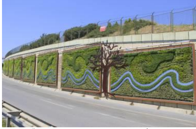
Şekil 17. Ünalın Dikey Bahçe Uygulaması, İstanbul (Url 16)
