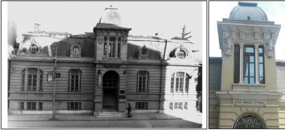
Şekil 14. Osmanlı Bankası Samsun Şubesi giriş cephesi (URL-10) ve anıtsal girişin birinci kat detayları (Aylin Kaya, 2019)
