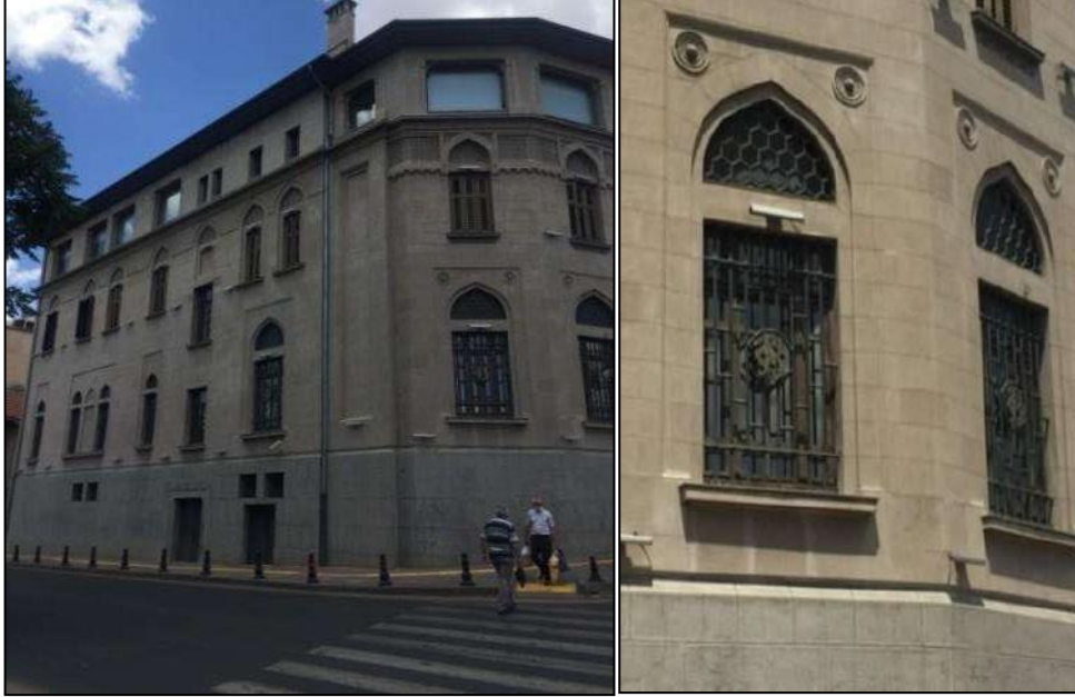
Şekil 21. Ankara Şubesi günümüz cephesi ve zemin kat pencere detayları (Aylin Kaya, 2020)
