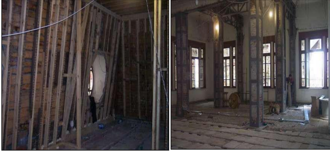
Şekil 18. Güçlendirme çalışmaları (Aylin Kaya, 2004)
