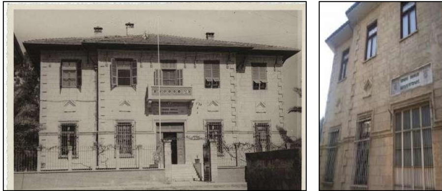
Şekil 27. Osmanlı Bankası Mersin Şubesi giriş cephesi, 1930 (URL-5) günümüz görüntüsü (Aylin Kaya, 2020)
