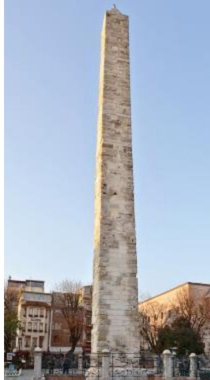
Şekil 3:Örme Dikilitaş, Sultanahmet Meydanı, İstanbul (2018)
