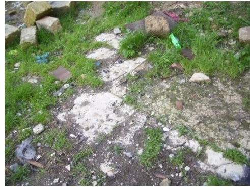
Şekil 11: Zemin döşemesi (M. Eyyamoğlu 2013)
