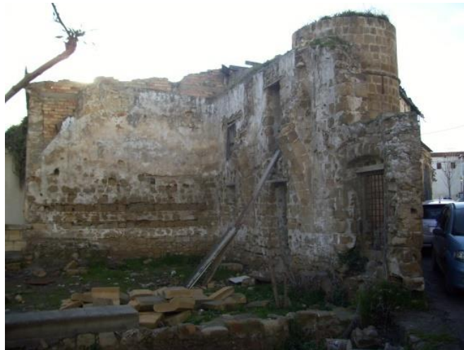
Şekil 5: Yapının ayakta kalan tek kısmı, kuzey-batı cephe ve minare (M. Eyyamoğlu - 2013)
