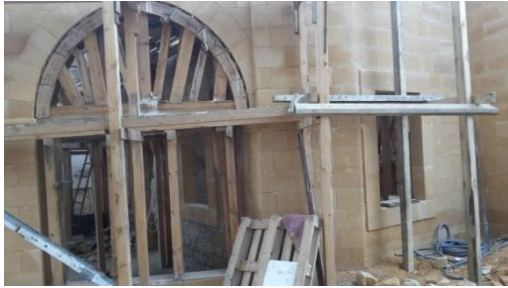
Şekil 15: Kuzey cephesi, kemer ve pencere (M.Eyyamoğlu - 2018)
